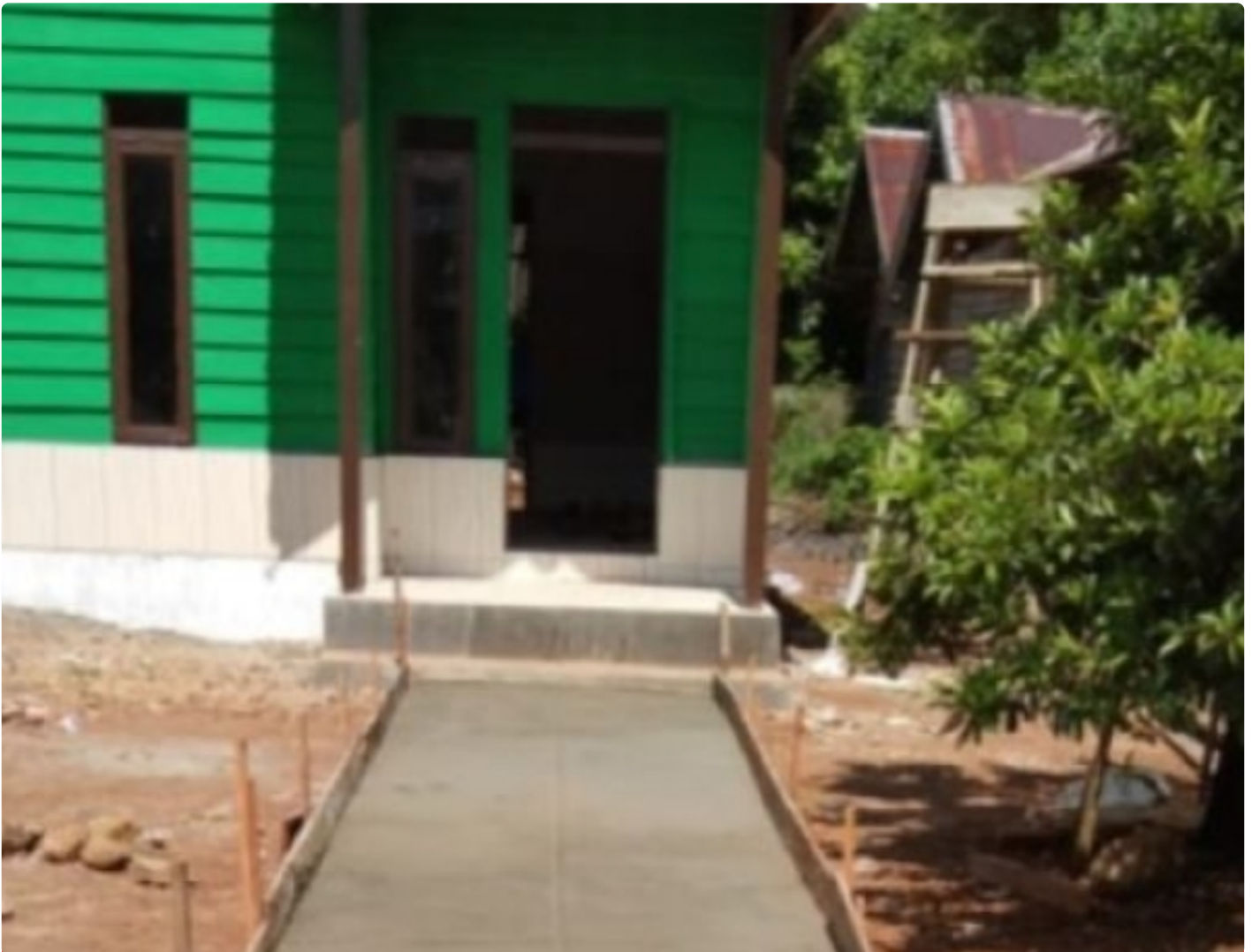
Jalan Masuk Rumah Nenek Marawiyah di Semenisasi Satgas TMMMD ke-113 Kodim 1006/Banjar
