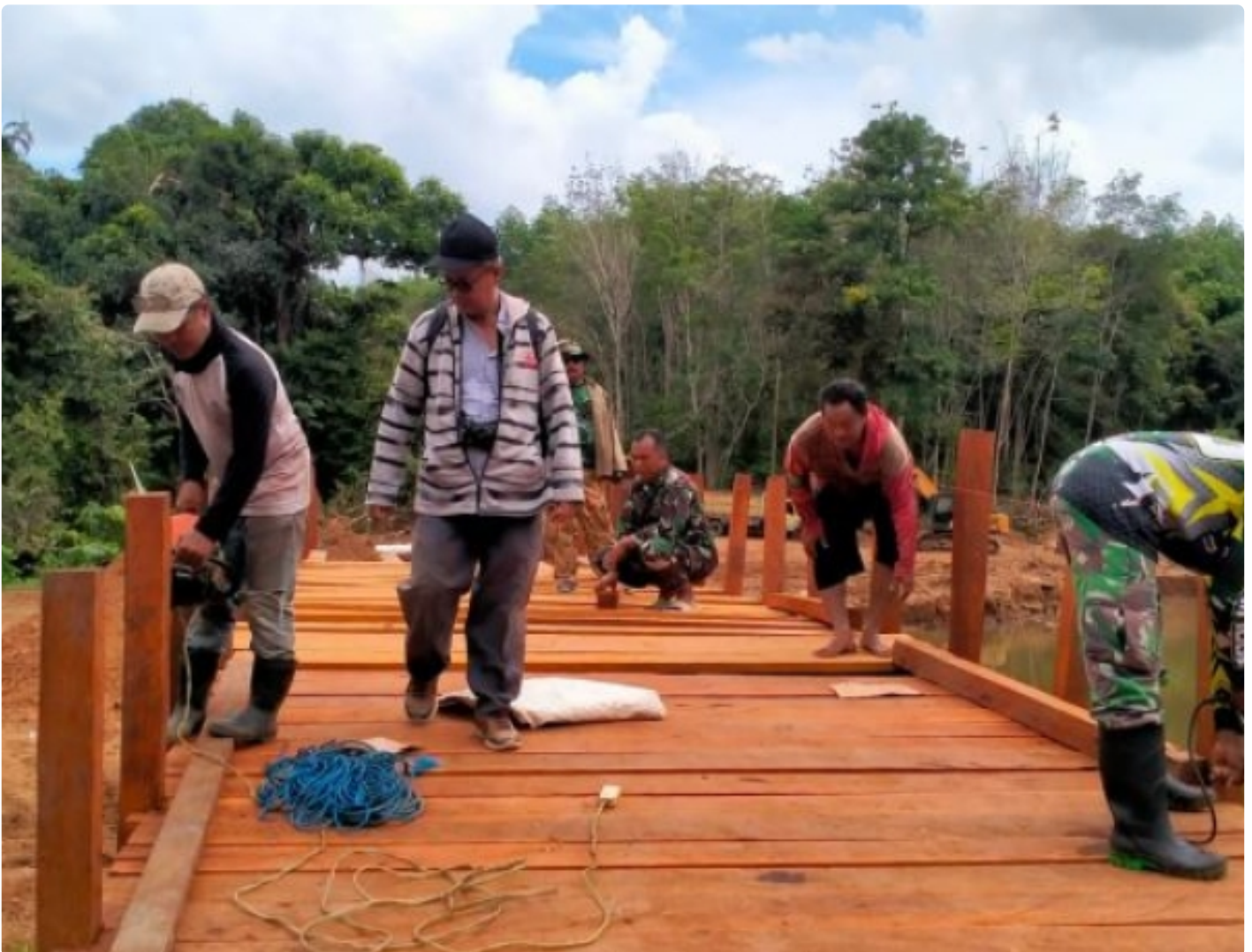
Satgas TMMMD Ke-113 Kodim 1006/Banjar Kebut Pengerjaan Jembatan Penghubung
